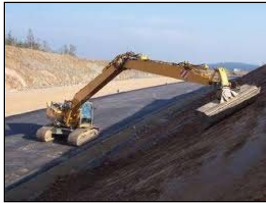
Figure 8 : Talutage en déblais
