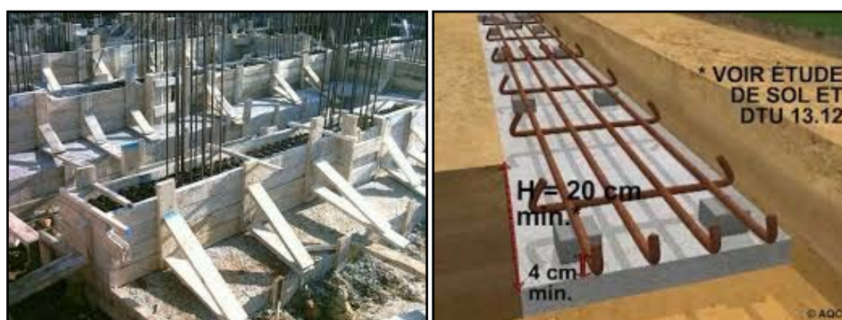
Figure 25 : Coffrage et ferrailage d'une semelle filante
