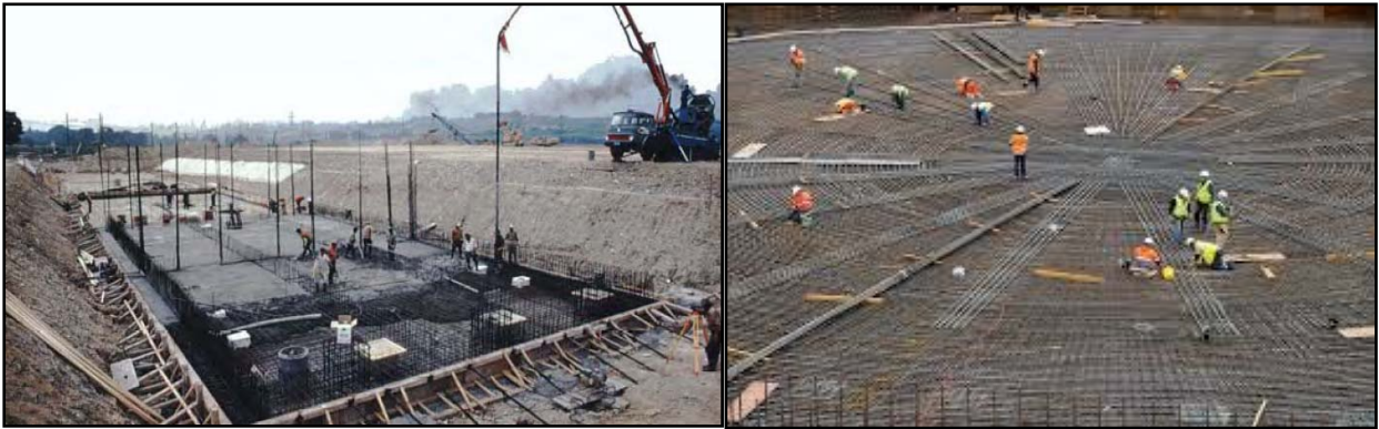
Figure 27 : Ferrailage et bétonnage de Radiers
