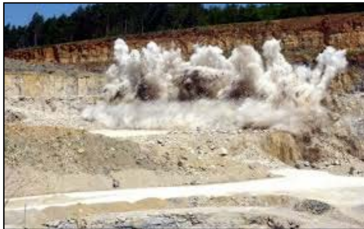
Figure 18 : Dislocation par explosif
