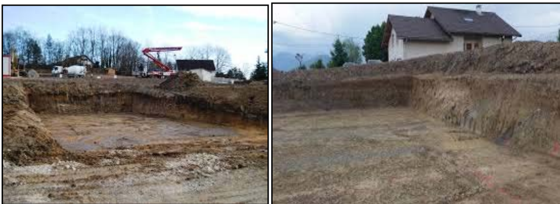
Figure 3 : Fouille en pleine masse
