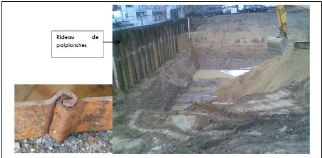
Figure 14 : Illustration de la serrure et d'un rideau de palplanches
