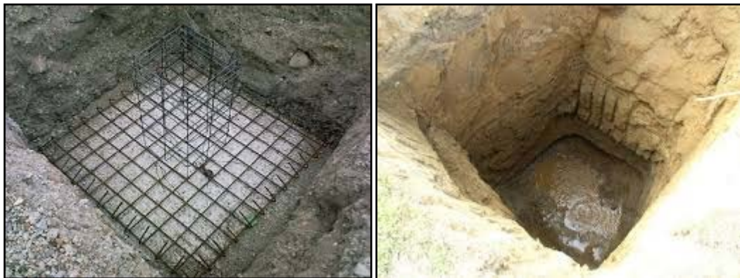
Figure 5 : Fouille en puits
