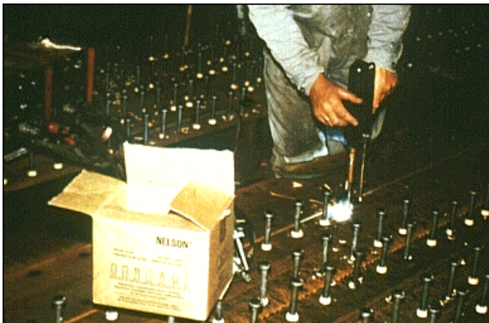
Figure 10 : exemple de mise en place de goujons sur des poutres en atelier.
