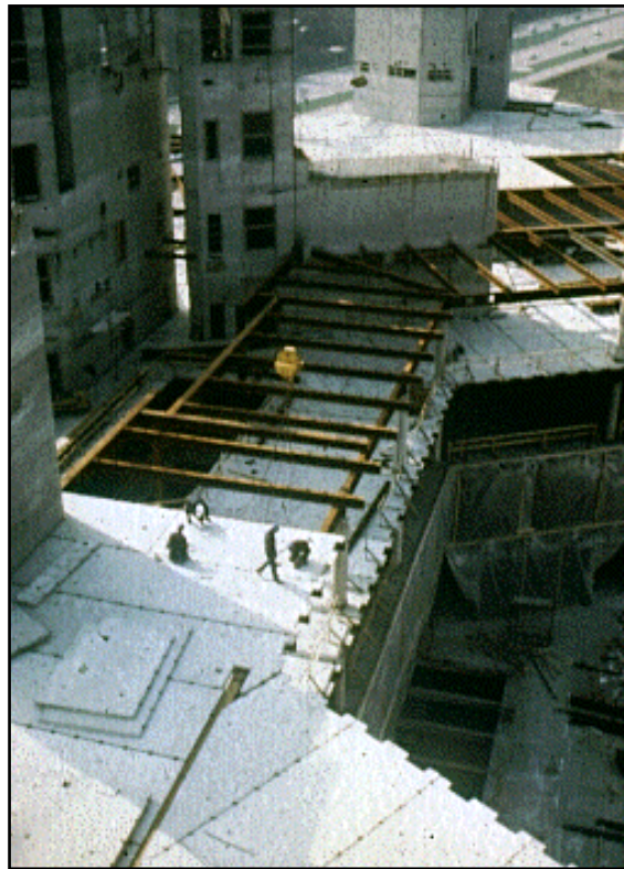
Figure 06 : exemple de plancher préfabriqué.
