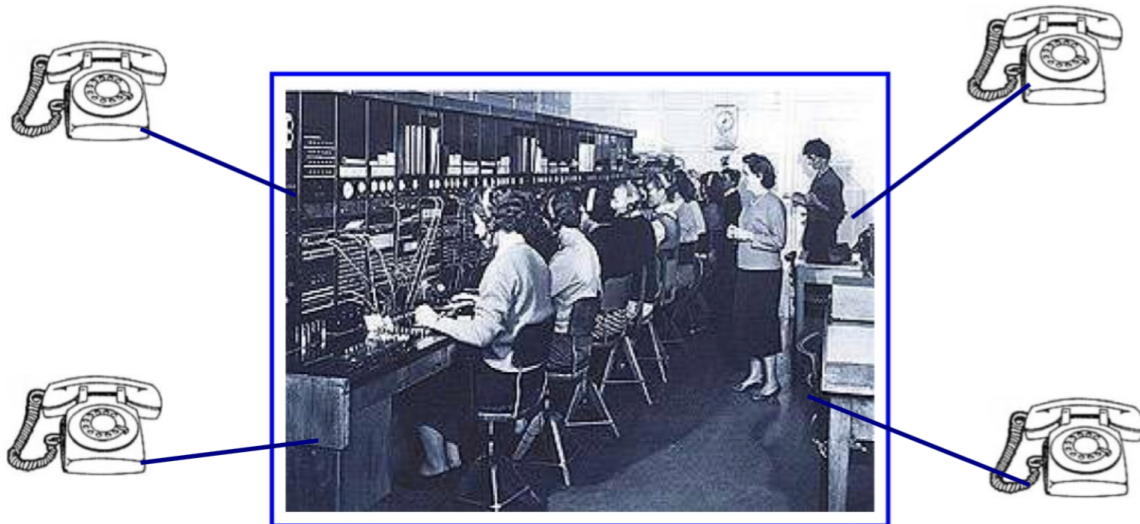
Figure II.7. La commutation manuelle avant les CAA
