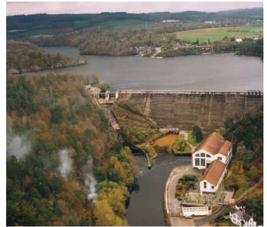
Crédits : Barrage de Guerlédan (22), EDF
