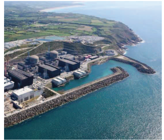
Crédits : Centrale de Flamanville (50), EDF
