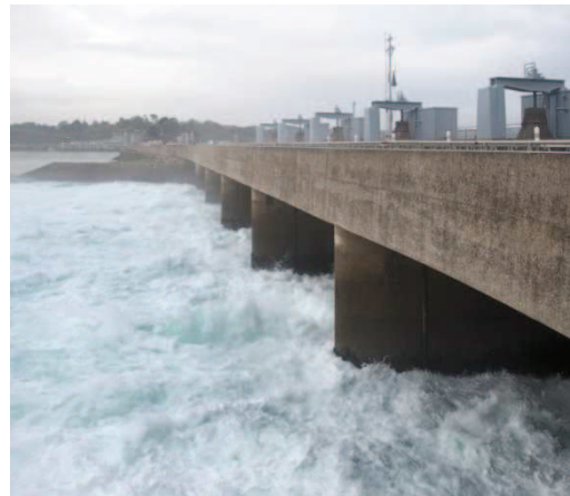
Crédits : Usine de la Rance (35), METL-MEDDE
