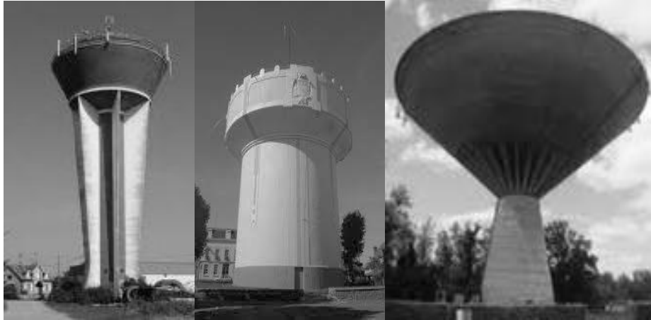
Figure 2. 2. Différentes formes de réservoirs (site web : www.panoramio.com )
